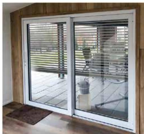
Die abgebildeten Hebeschiebetüren zeichnen sich durch eine barrierefreie Schwellenausführung aus. Weiterhin haben Hebeschiebetüren große Durchgangsöffnungen, ohne dass Öffnungsflügel in den Raum aufschlagen. Auch hier können sämtliche, sicherheitsrelevante Komponenten ausgeführt werden.
